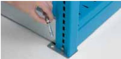
Für die Fußbodenbefestigung muss für jede Fußplatte ein Dübel mit einem Zugwert (inklusive Sicherheitsfaktor) von **4,3 Kn** benutzt werden.
